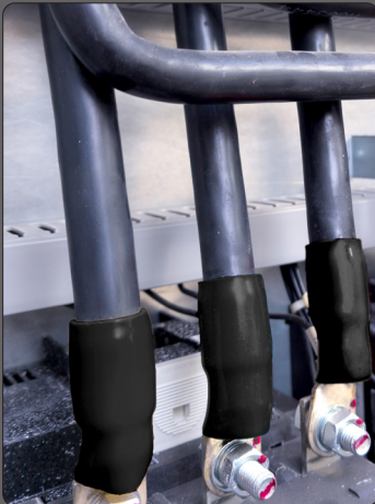
Герметизация кабельных жил и наконечников.
